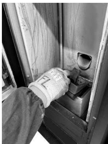
Fig. 33 - Verwijdering vuurpot
