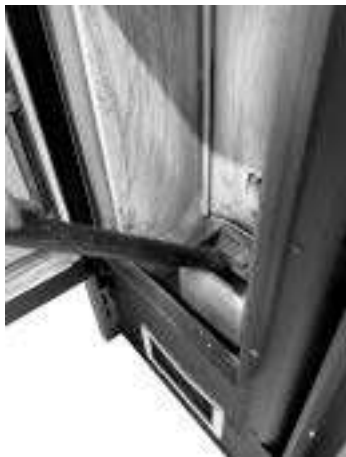
Fig. 35 - Reiniging ruimte vuurpot
