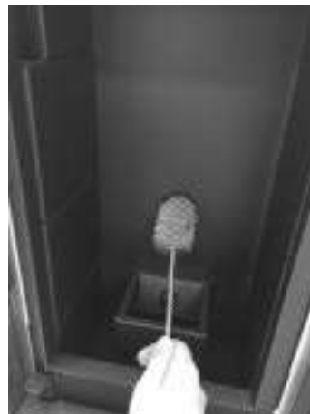
Fig. 36 - Reiniging met flessenwisser
