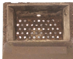
Verbrandingspot met verstopte gaatjes en openingen die dus moet worden schoongemaakt
