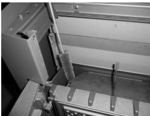
Figuur 13 - Rookgaskanalen reinigen
