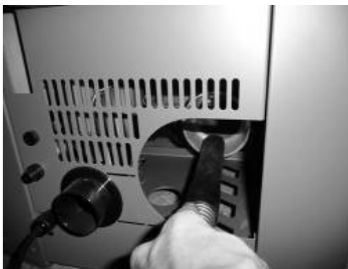
Figuur 16 - Stofzuigen rookgasuitlaat
