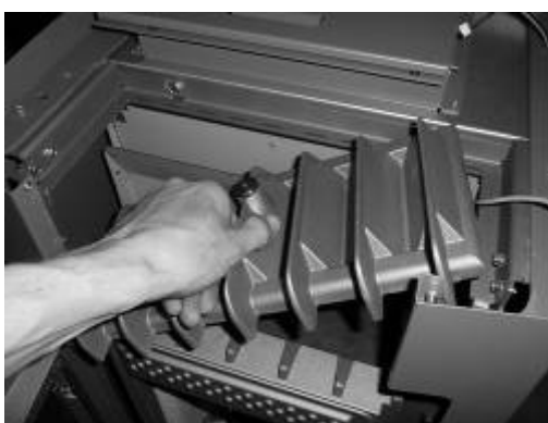
Figuur 12 - verwijderen gietijzeren deksel
